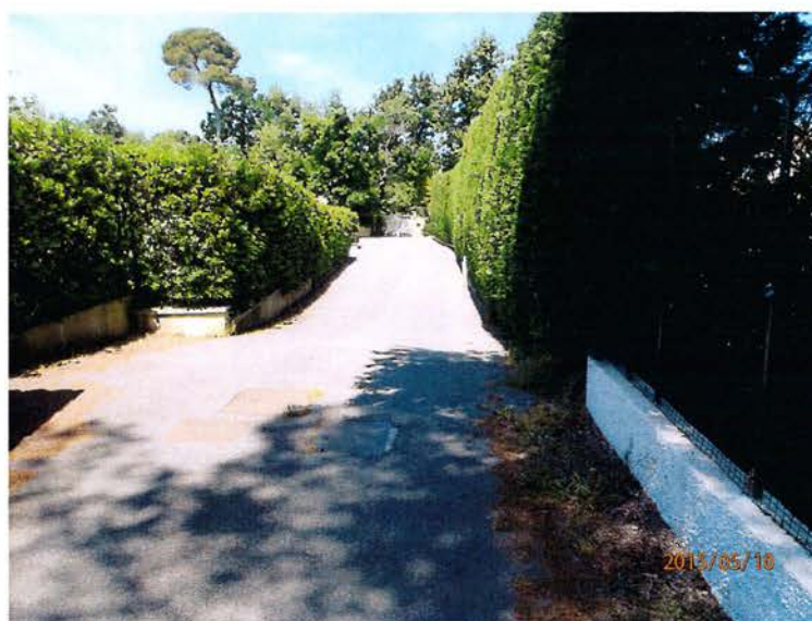
Photo n°10 : zone en affaissement dans le quartier de la Nartassière
