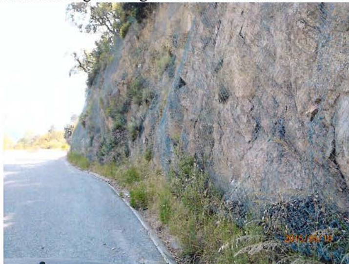
Photo n°14 : grillage de protection sur les gneiss En amont des Canebiers
